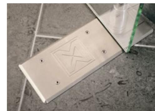
Gefrästes Abdeckblech des Bodentürschließers
